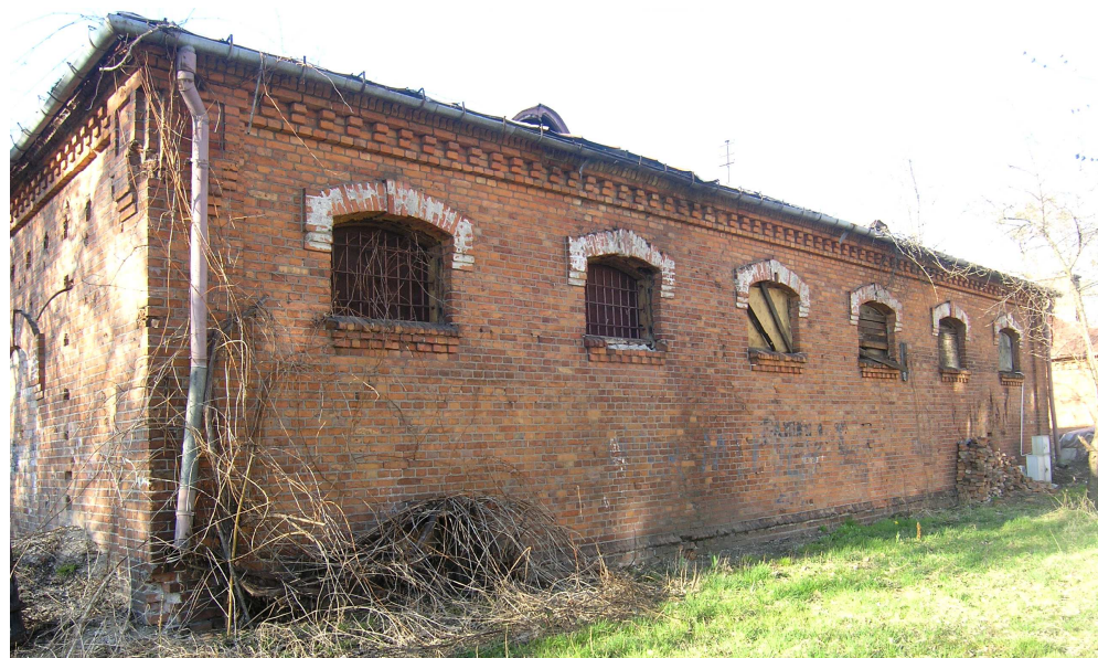
Elewacja tylna od południowego-zachodu.
