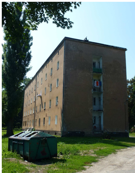
Widok od strony północnej.
