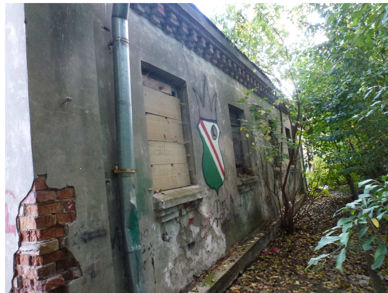
Widok na elewację tylną
