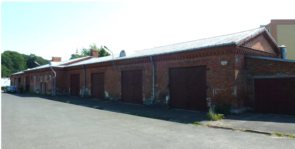
Widok na elewację tylną budynku
