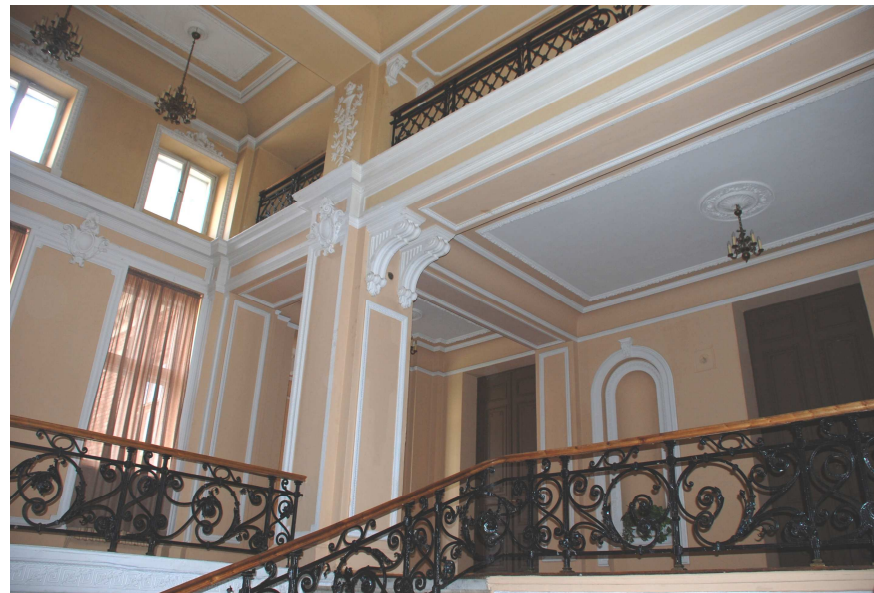
Widok na sień z ciągiem schodów wewnątrz budynku
