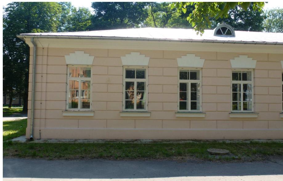
Widok fragmentu elewacji od północnego-wschodu
