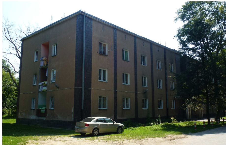
Widok od północno-zachodu
