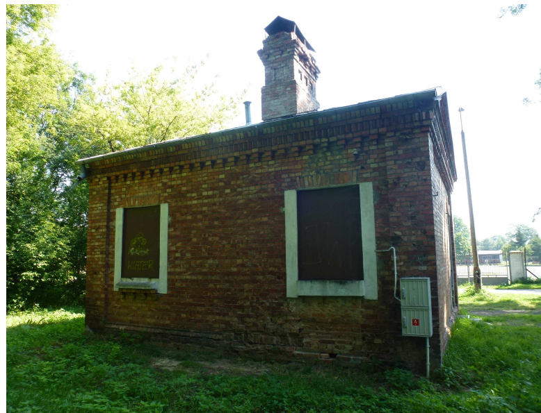
Widok od strony zachodniej
