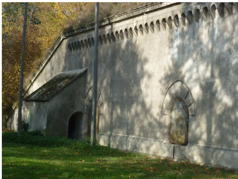
Widok na zachodnie otwory wejściowe do wnętrza prochowni.
