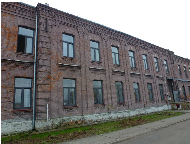
Widok środkowego ryzalitu elewacji frontowej
