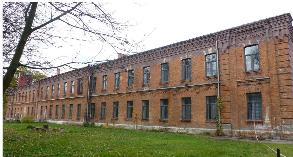
Widok na elewację tylną od strony południowo-wschodniej
