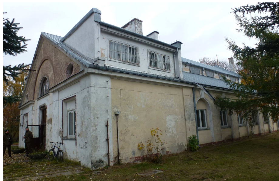
Widok od strony południowo-zachodniej
