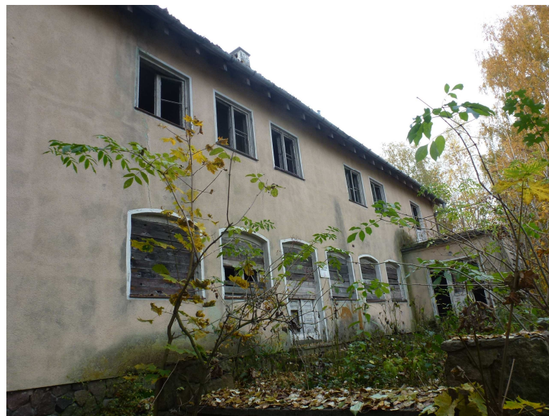
Widok od strony północno-wschodniej
