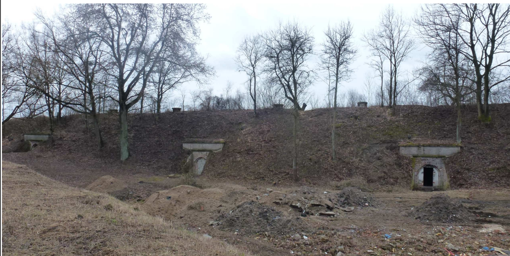
Widok od strony północnej
