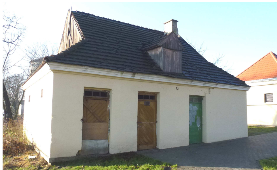
Widok na elewację wschodnią budynku
