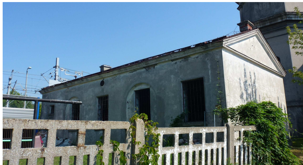
Widok na elewację zachodnią.
