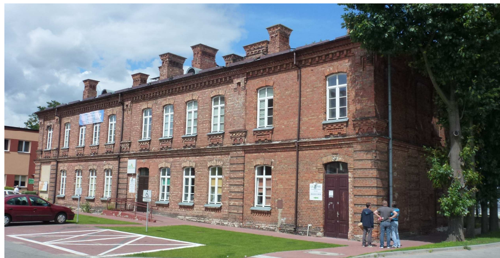
Widok od strony południowo-zachodniej.
