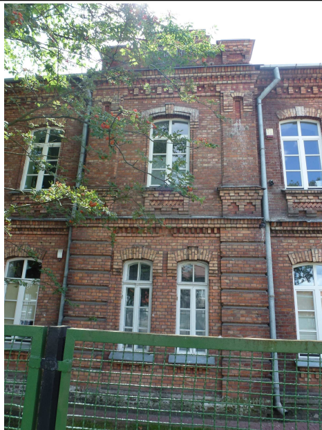
Widok na ryzalit elewacji frontowej
