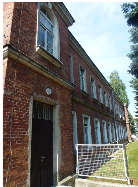
Widok na elewację tylną (wschodnią).
