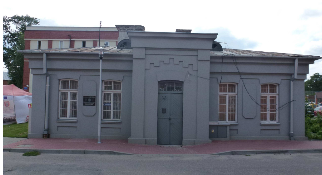
Widok na elewację frontową
