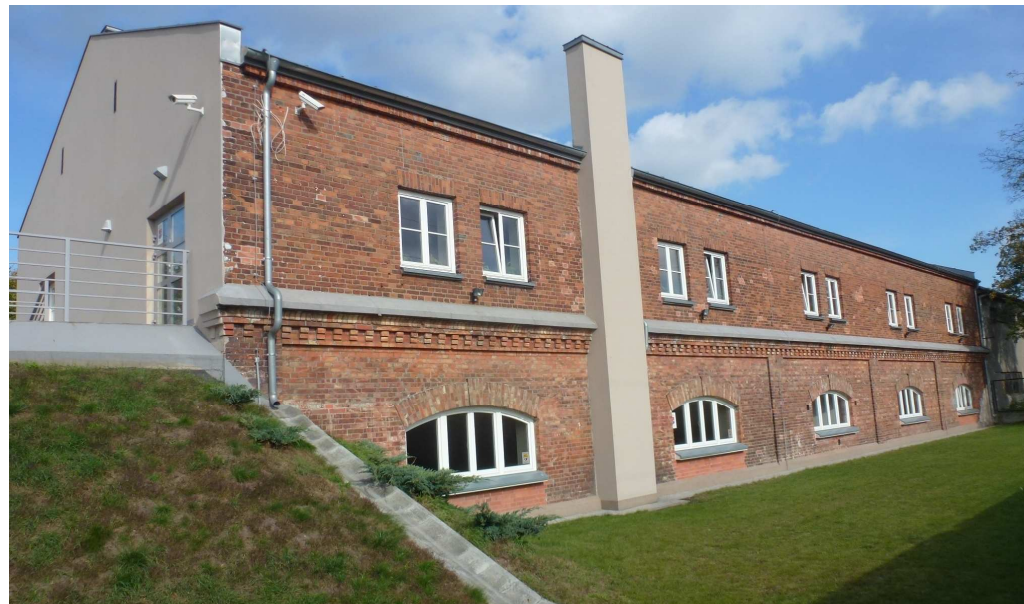
Widok na elewację tylną od strony południowo-zachodniej
