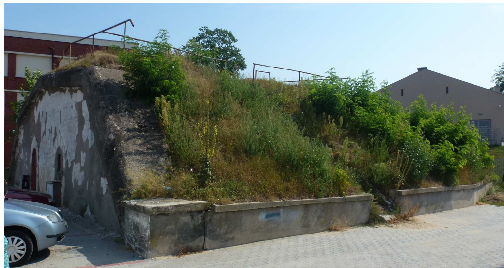
Widok od strony zachodniej.
