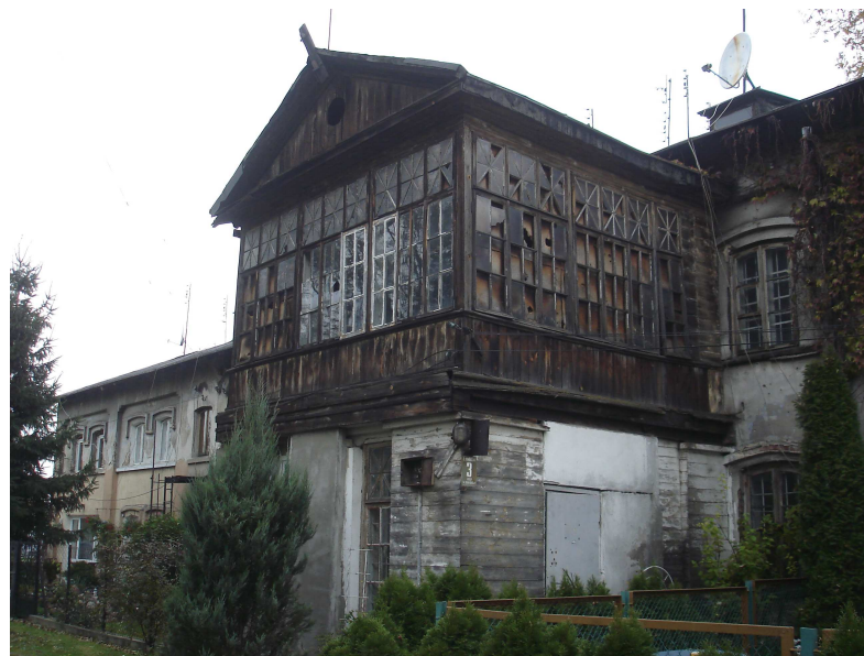
Widok na werandę w południowej elewacji budynku
