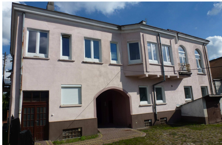
Widok na elewację tylną budynku od północno-zachodu
