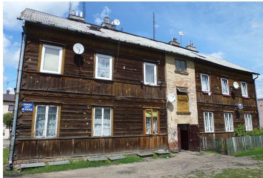
Widok od strony południowej.
