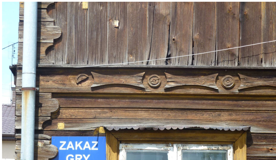
Fragment detalu na elewacjach.
