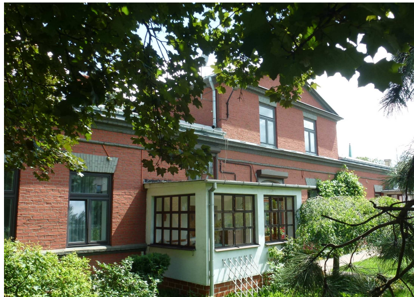
Widok na elewację tylną (zachodnią)
