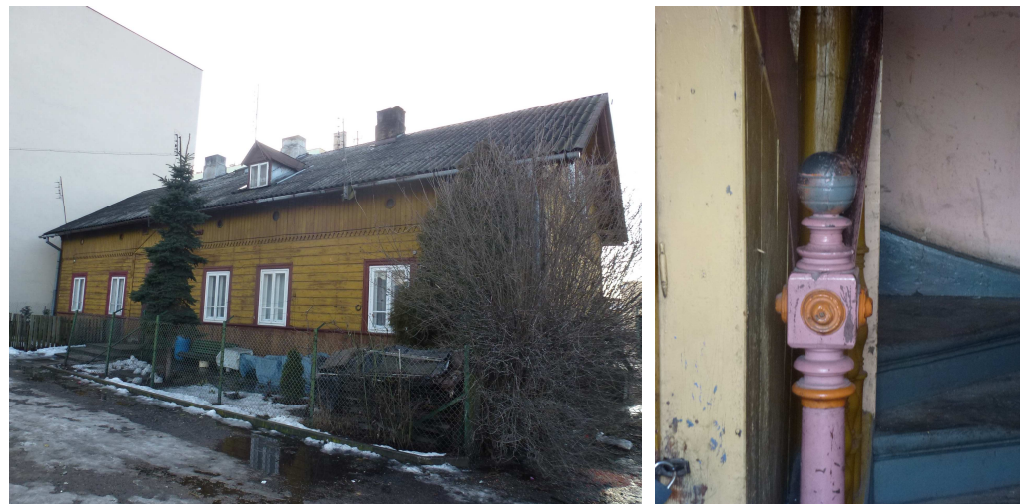
Widok tylnej elewacji i detal poręczy klatki schodowej
