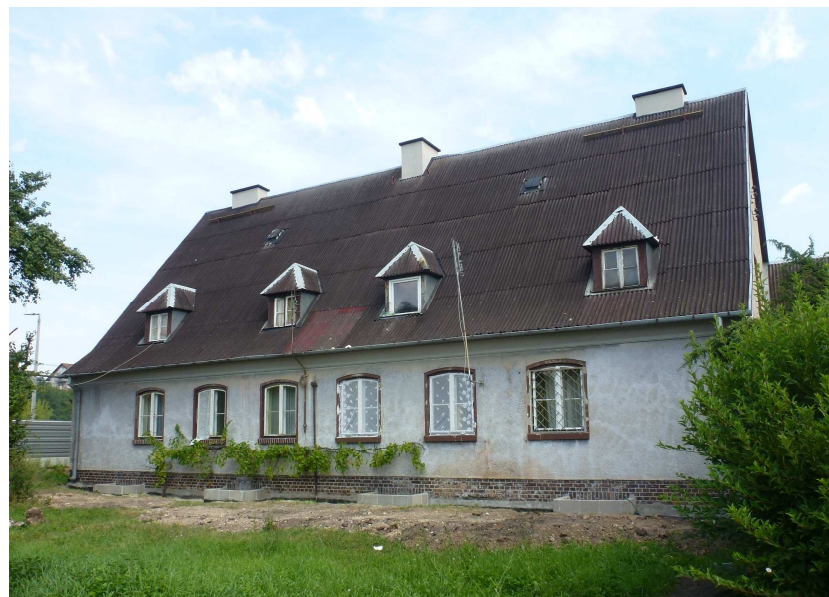
Widok od strony południowo-zachodniej.
