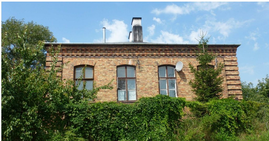
Widok na elewację południową.
