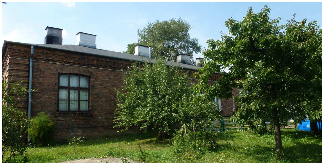
Widok na elewację ogrodową (wschodnią)
