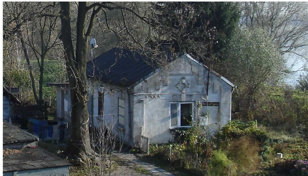
Zachowany dom mostowego.
