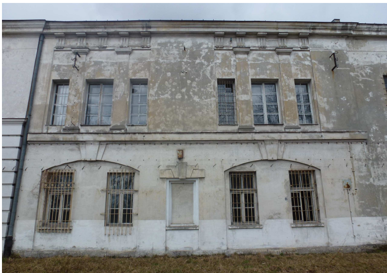
Powtarzalny moduł w skrzydle północnym koszar
