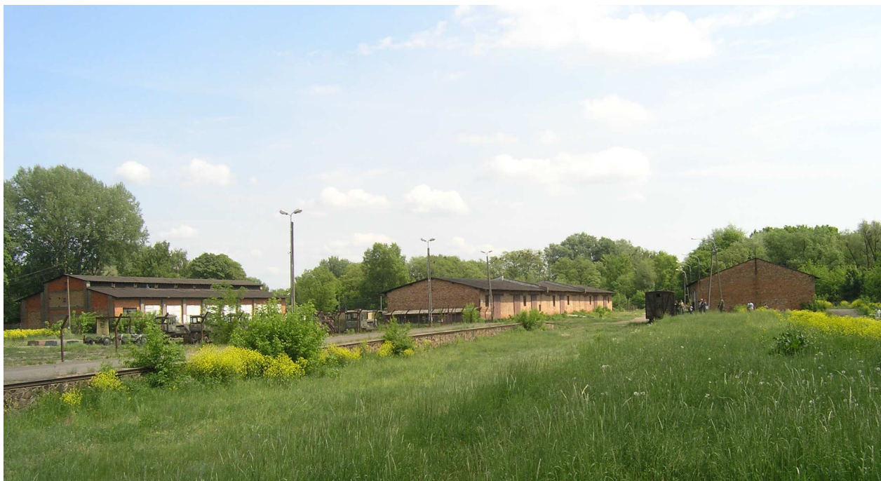
Budynki warsztatowe z rampami kolejowymi
