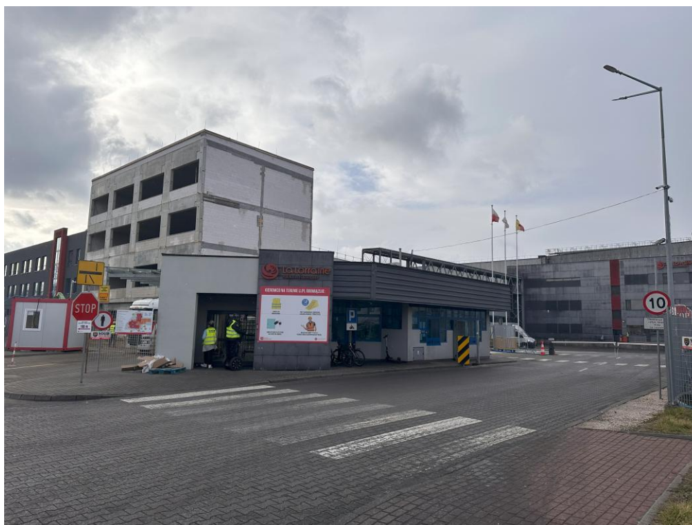
Fot.5 Wjazd do zakładu La Lorraine
