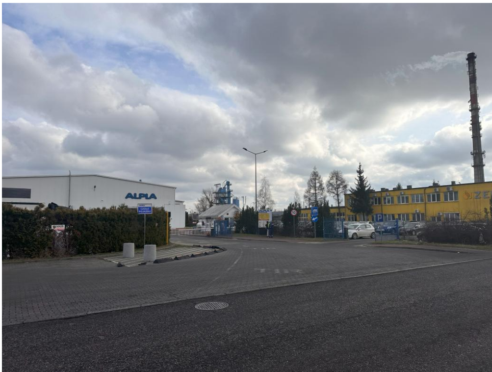
Fot.4 Wjazdy do zakładów z istniejącej ulicy
