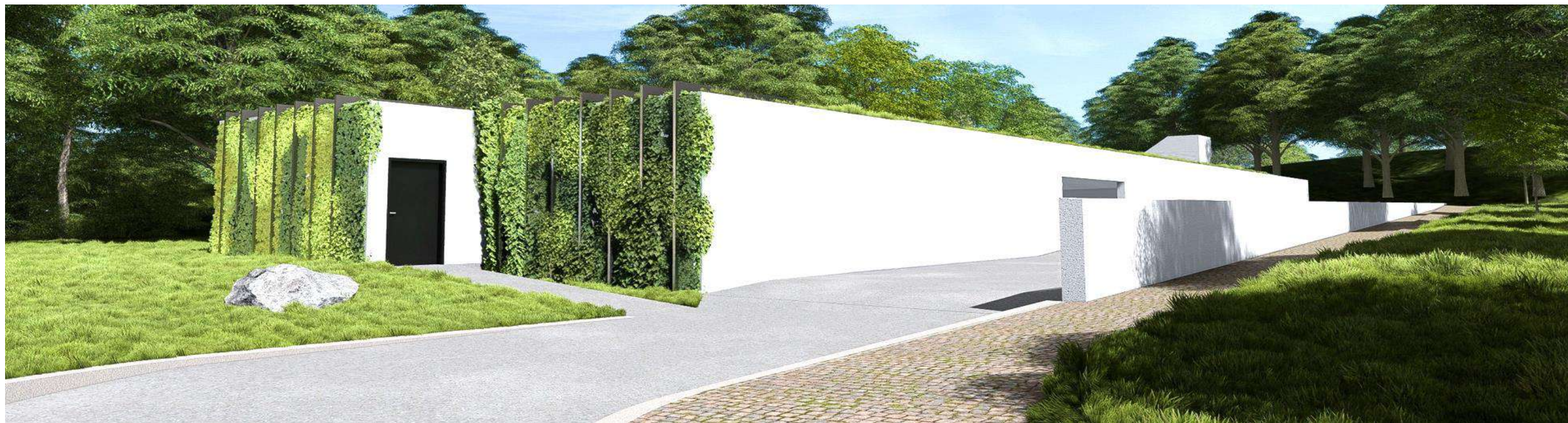
Ilustracja 6. WIDOK BUDYNKU GARAŻOWEGO OD STRONY WJAZDU Z ULICY AKACJOWEJ
