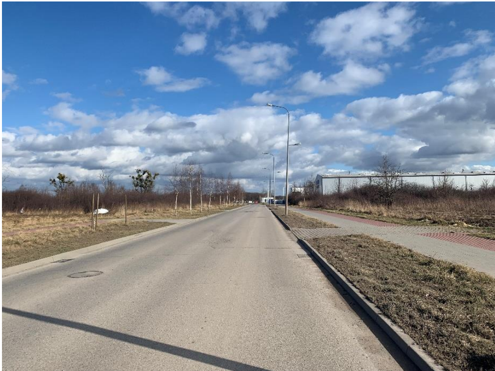
Fot. 1. Droga obsługująca istniejące obiekty przemysłowe
